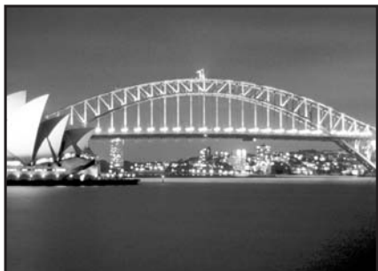
Fig. 31 - Exemples de pont à arches en acier
