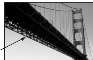
Fig. 49 - L'utilisation de poutres triangulées sur le tablier d'un pont suspendu
